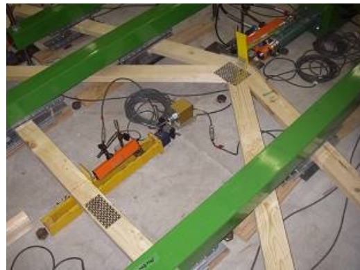
中央変位計の設置
