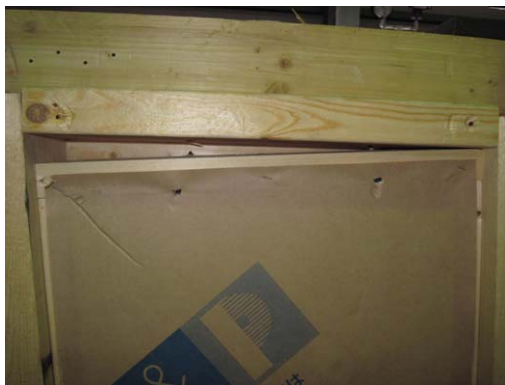
写真 7.1.13 壊後の様子(一丁継ぎ-3) パネルと枠材とのずれ
